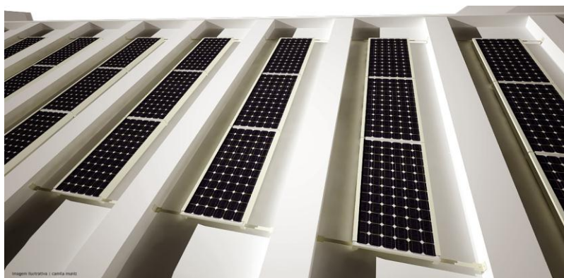
Fig. 5.5 – Projeto fotovoltaico da BPE/RJ: pontuação contribuirá para pontuação maior do LEED.
