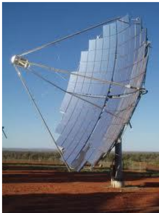
Fig. 3.6 Sistema concentrado fotovoltaico (CPV) utilizando espelhos parabólicos.
