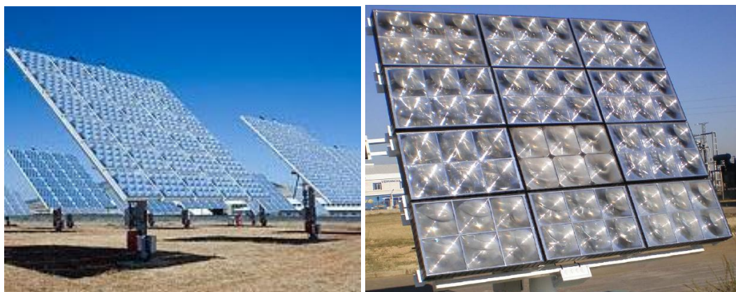
Fig. 3.7 Sistema concentrado fotovoltaico (CPV) com emprego de lentes de Fresnel.
