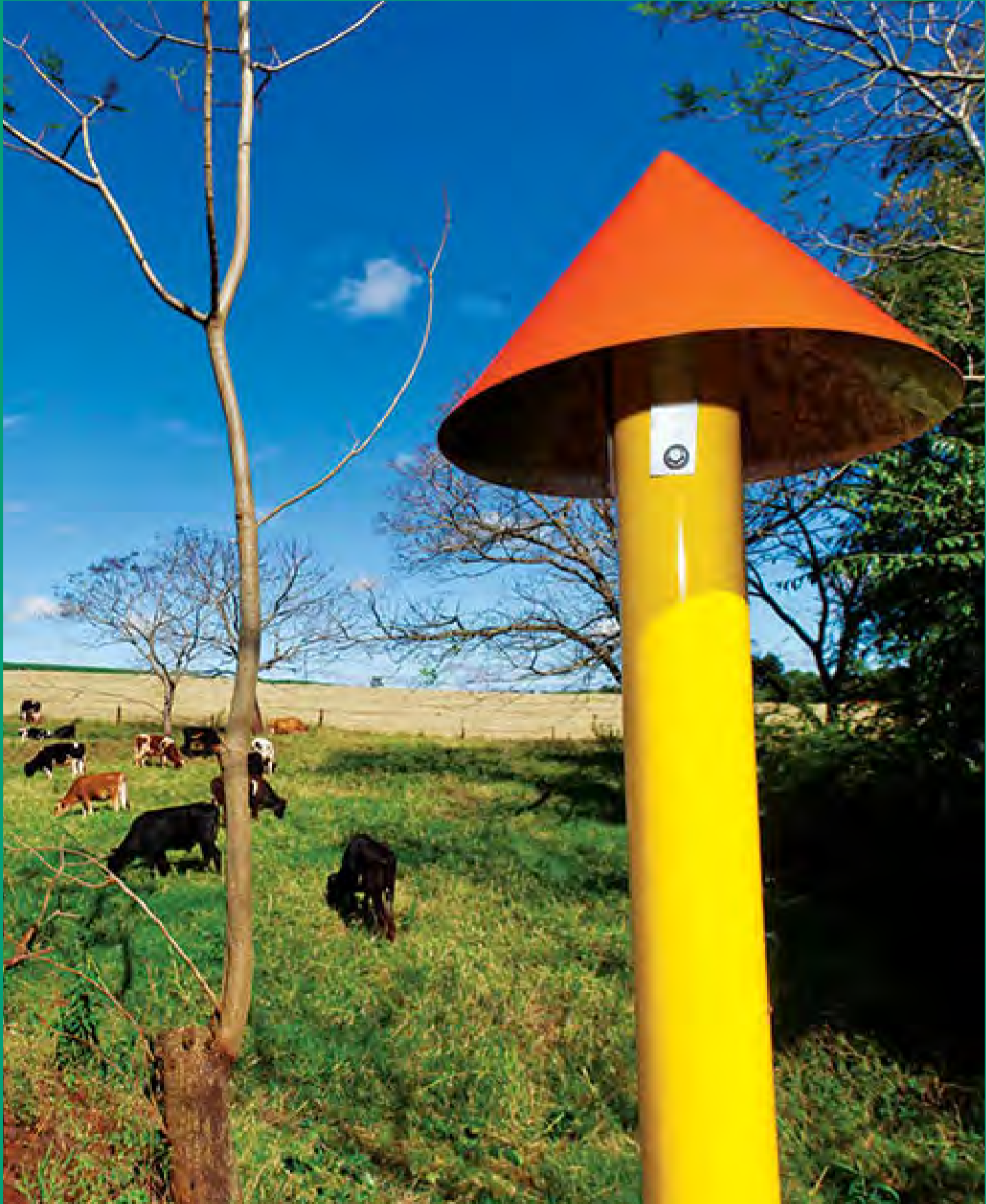
Identificação de gasoduto rural
