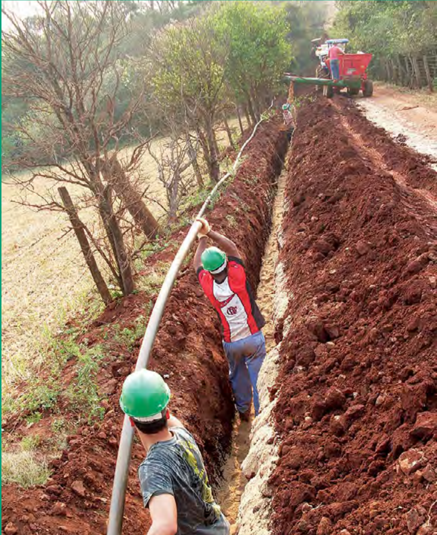
Instalação de gasoduto rural
