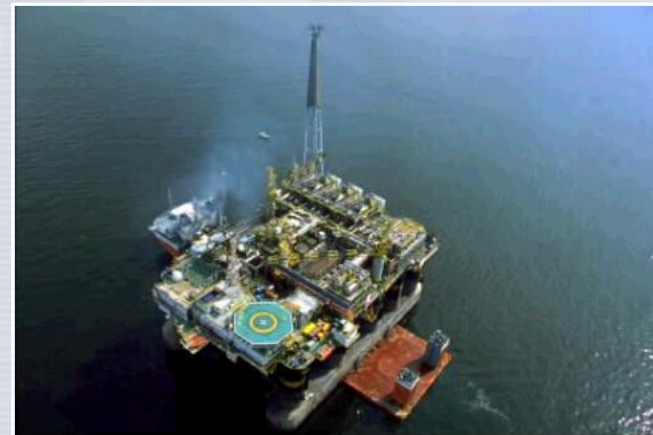
Plataforma P-40 20 MW
