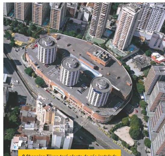
O Shopping Tijuca terá planta de gás instalada pela Sotreq operando em regime turn-key
