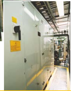
Motogerador CAT, encarenado para isolamento acústico, produz 300 kW de energia elétrica, 140 TR de água gelada e calor de conforto (água quente) no Sofitel
