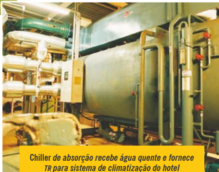
No Caesar Park, motogerador e trocador de calor ficam no térreo. Tubulações levam água e calor reaproveitados para o andar superior
