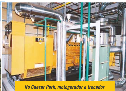
No Caesar Park, motogerador e trocador de calor ficam no térreo. Tubulações levam água e calor reaproveitados para o andar superior
