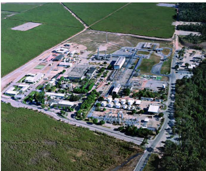
A UPGN-AL da Petrobras, localizada em Pilar, próximo ao aeroporto, fornecerá o gás natural para o sistema de cogeração através da rede da Algas
