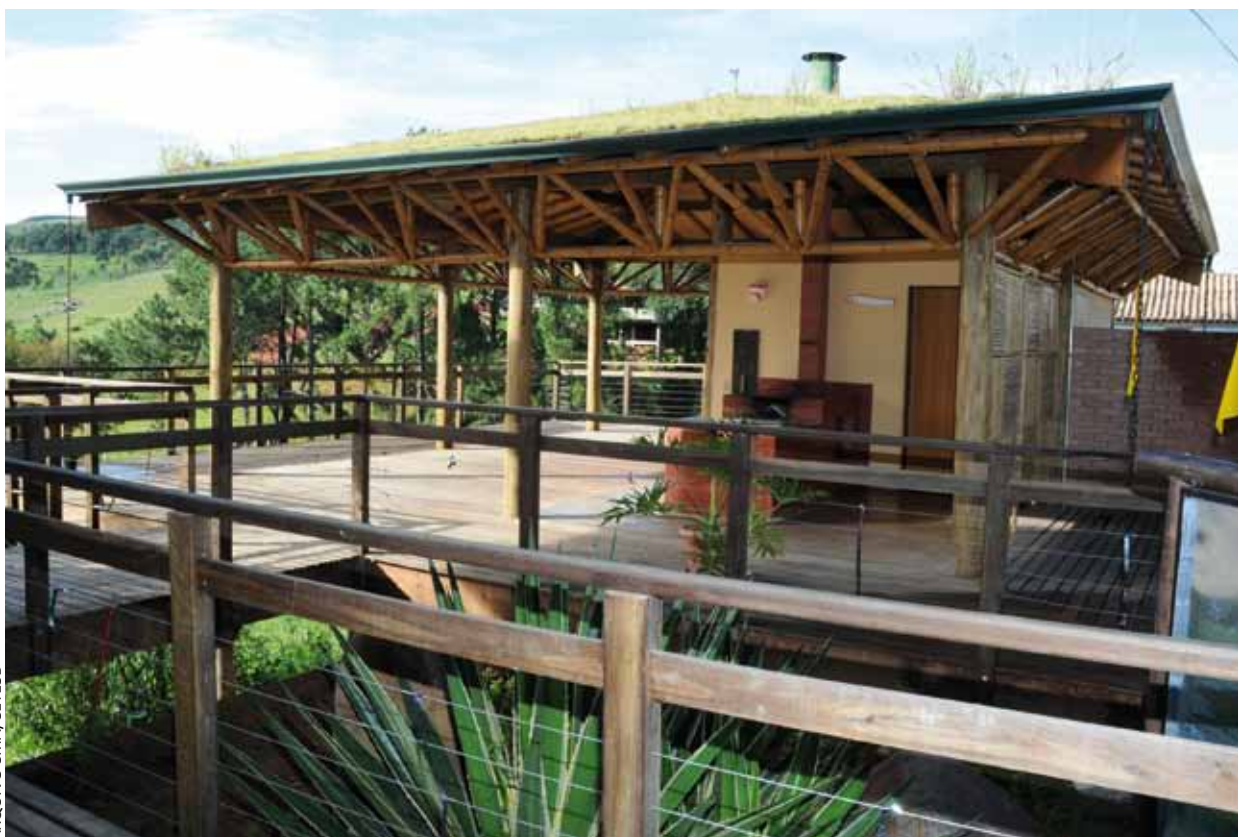
Casa do Artesão em Piracaia: construção com sustentabilidade.
