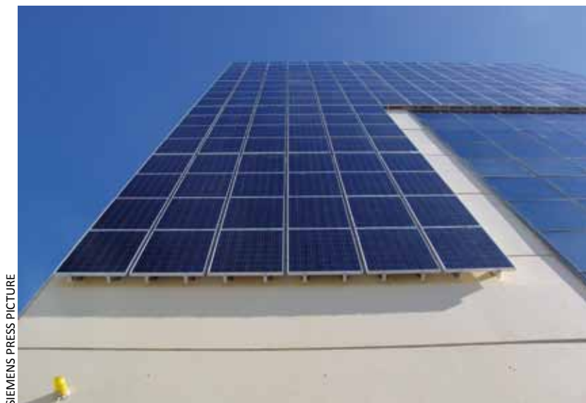
Painéis solares verticalmente instalados em edifício: um exemplo de autogeração.
