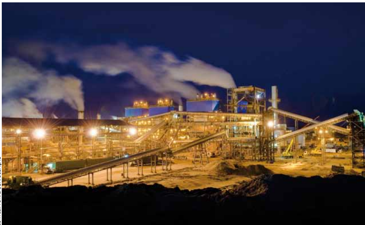
Usina de biomassa no oeste do Estado.
